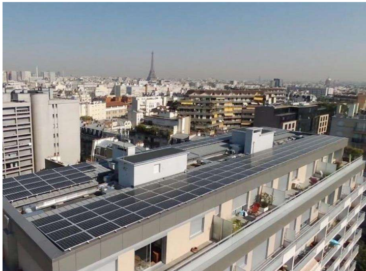
Copropriété Rue de Vouillé à Paris
